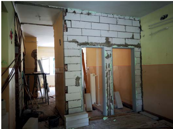
Üllés Szabadság téri Egészségház felújítása és átalakítása
