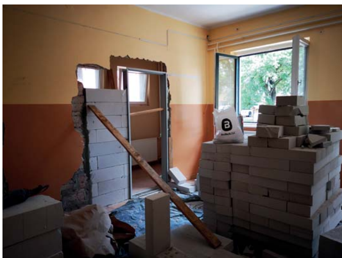
Üllés Szabadság téri Egészségház felújítása és átalakítása
