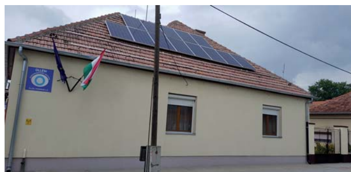
Üllési Önkormányzati Konyha épületének energetikai korszerűsítése
